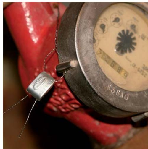
Для контроля доступа к контрольно-измерительным приборам и счетчикам
